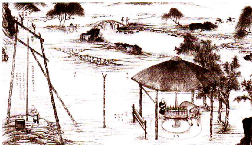
Mélyfúrás technikája víz, sólé és földgáz kitermelésére. Az utóbbihoz nyomáscsökkentőket, kitörésgátlókat, elzárócsapokat is kellett gyártani. A technológia exportképes lett volna a szomszédos Közel-Keleten és Perzsiában.
